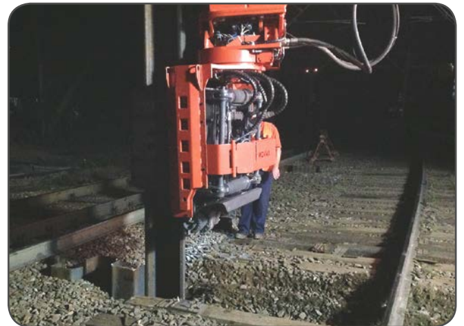
Rinforzo ferroviario, Belorechensk, Russia
