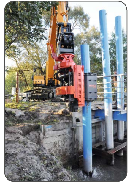
Palancole tubulari in acciaio, Polonia
