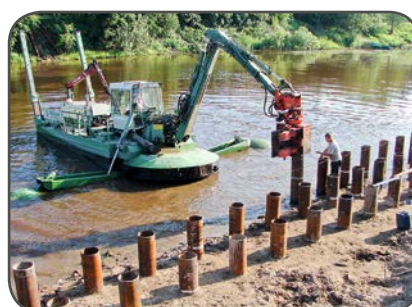
Palancole tubulari in acciaio, Russia
