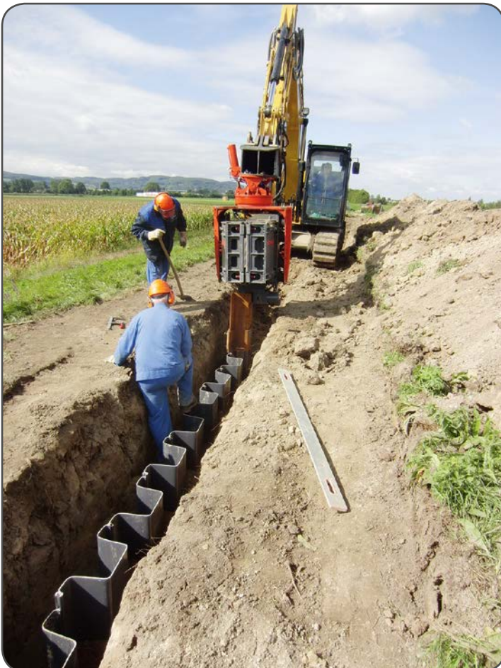
Infissione di palancole in vinile, Programma di prevenzione delle inondazioni, Austria
