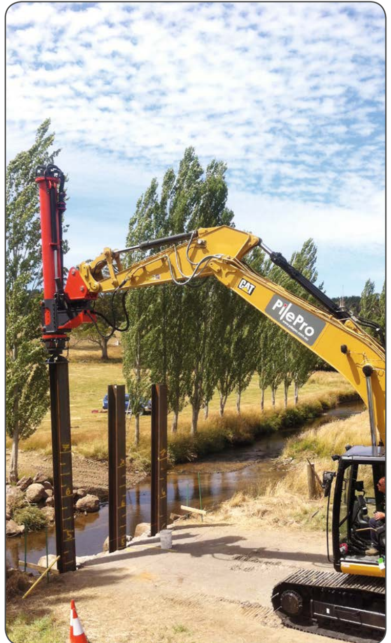
Palancole a H, prove di carico, Australia
