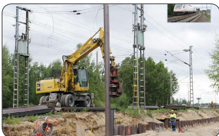
Infissione di palancole, Finlandia
