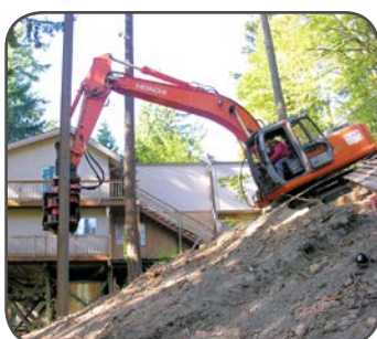
Chiodatura del terreno, Stati Uniti
