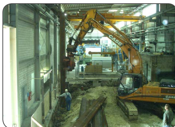
Infissione di palancole in interni, Germania
